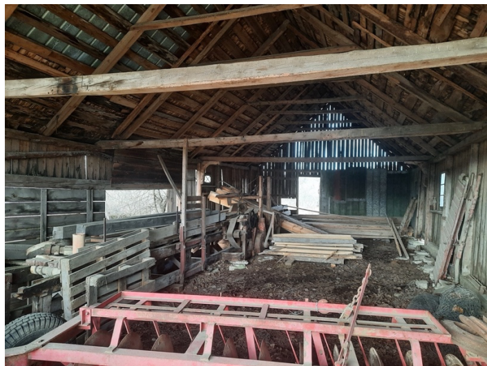
Figur 7.7 Tydlig avläsbarhet vart lokomobilen varit placerad, brännmärken efter dess skorsten till vänster på första bindbjälken.
